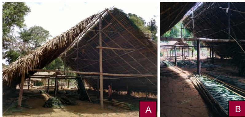
Figura 26 - Início da construção da oca na parte superior do terreno.
